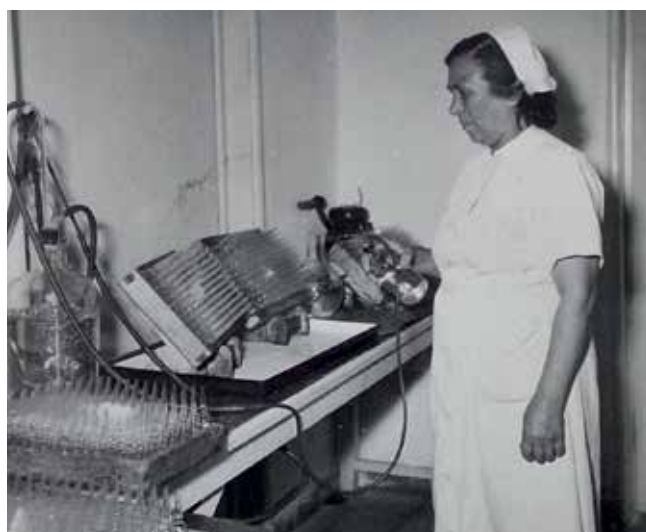
Почистване на заредените ампули със силно пулверизирана дестилирана вода
