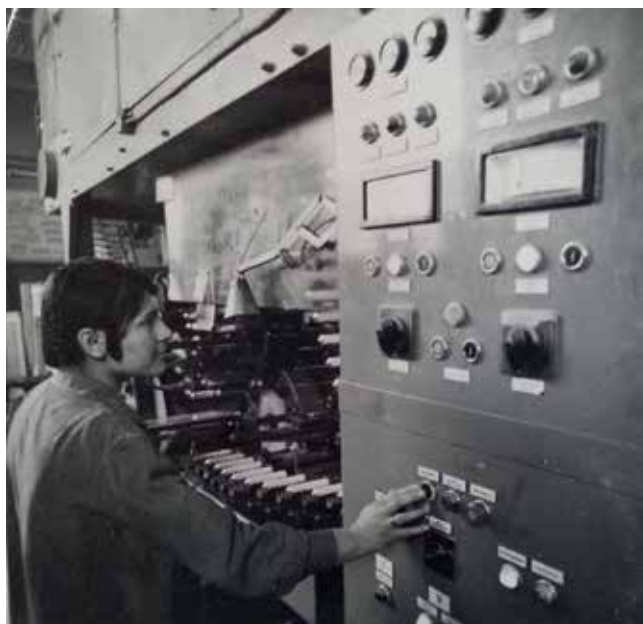
Автоматична поточна линия за пълнене на туби в цех „Галеника“. ЦДА, Албум 6 Д
