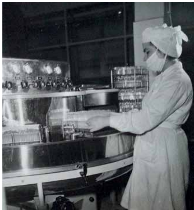
„Щрунг” машина за вътрешно измиване на ампулите
