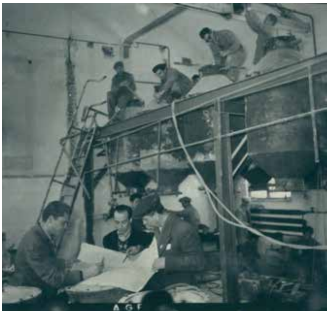
Монтиране на дифузионна апаратура в Химичния цех. София, 1956 г. ЦДА, Албум 6Д
